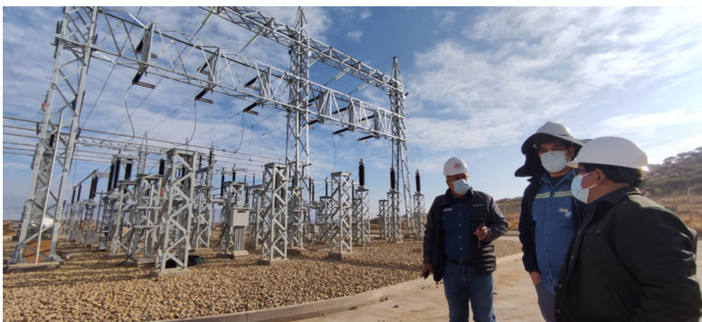
Inspección técnica Subestación La Angostura
