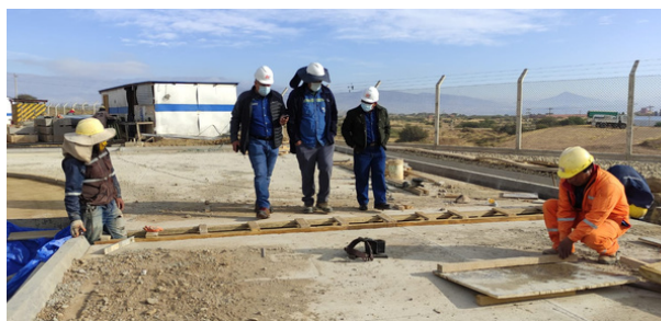
Inspección técnica a la conclusión de obras civiles y la Sala de Control, Subestación La Angostura en Tarija
