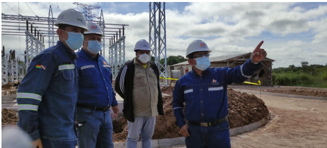
Inspección a obras en la Línea de Transmisión en alta tensión
