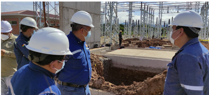
"Instalación de Sistemas de Distribución en la Subestación Bermejo"
